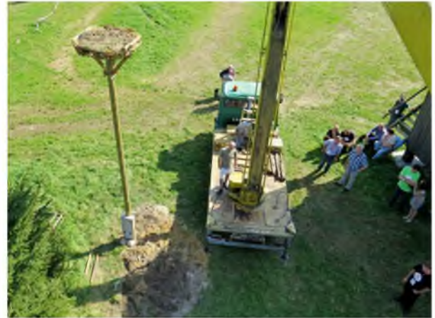
Рисунок 27. Процесс установки платформы завершен.
