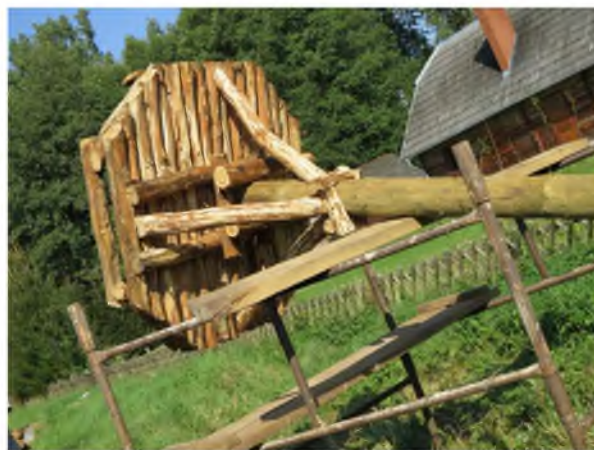
Рисунок 11. Деревянные детали платформы прочно соединены крупными гвоздями.
