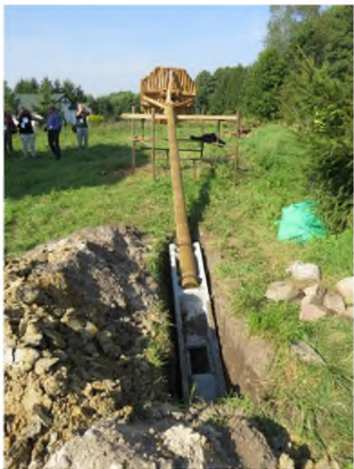
Рисунок 9. Конструкция (бетонное основание, деревянный столб и платформа для гнезда) изготовлены заранее. Также заранее вырыта яма для установки столба.
