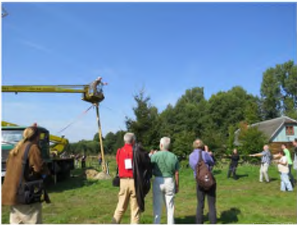
Рисунок 20. Нужно как минимум 2 крепких человека для стабилизации платформы, удержания ее за разные концы веревок-растяжек.
