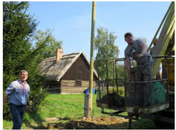
Рисунок 23. После того как опора прочно укреплена, с помощью песка и камней, на платформу поднимается выстилка будущего гнезда.
